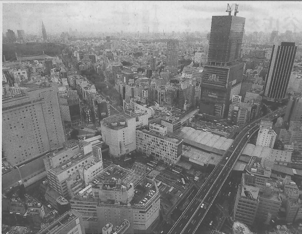
建設中のヒカリエを臨む(11年7月撮影)。街並みは劇的に変わるだろう
