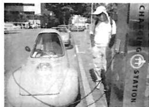
まちなかに設置されているEV充電ステーション
